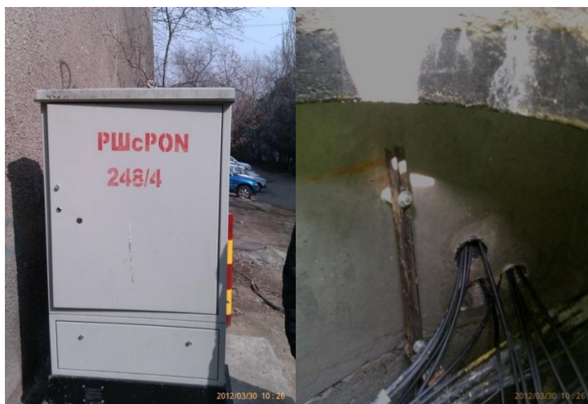
1.15 - сурет – Тығыздау технологиясының бұзылуы оптикалық кабельдің тығыздаудың болмауы
