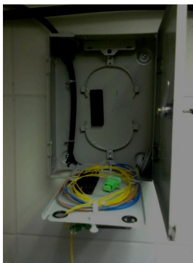
1.14 - сурет – Оптикалық қосқыш қорапқа оптикалық кабельдің дұрыс енгізілмеуі
